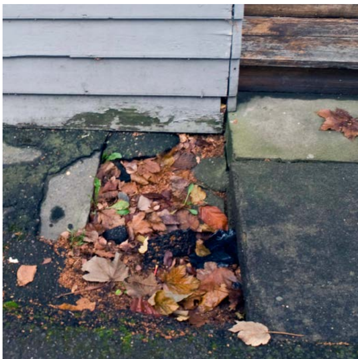
Vannrennen langs Nils Kjærs gate kunne vært effektiv men effekten er antagelig i stor grad borte pga gjen- groing, hull til grunnen og tildels manglende fall. Mulig rennen burde fortsatt ned til tverrgaten i øst. Slik det er nå bidrar rennen til fuktigere kjeller.
