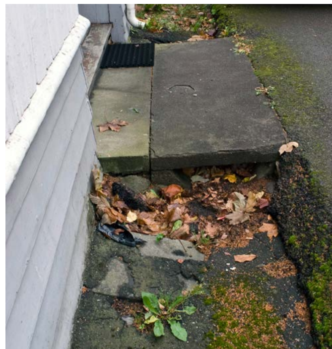
Vannrennen langs Nils Kjærs gate kunne vært effektiv men effekten er antagelig i stor grad borte pga gjen- groing, hull til grunnen og tildels manglende fall. Mulig rennen burde fortsatt ned til tverrgaten i øst. Slik det er nå bidrar rennen til fuktigere kjeller.
