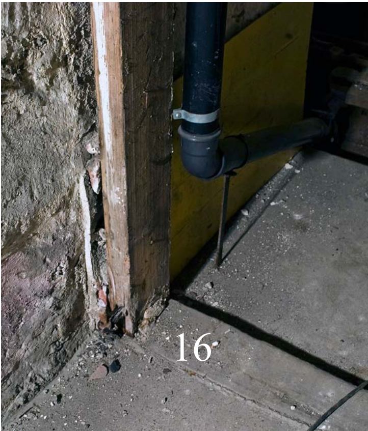
Over. Råteskade i gammel karm mellom eldre og yngre kjeller. Nederst i karmen.
