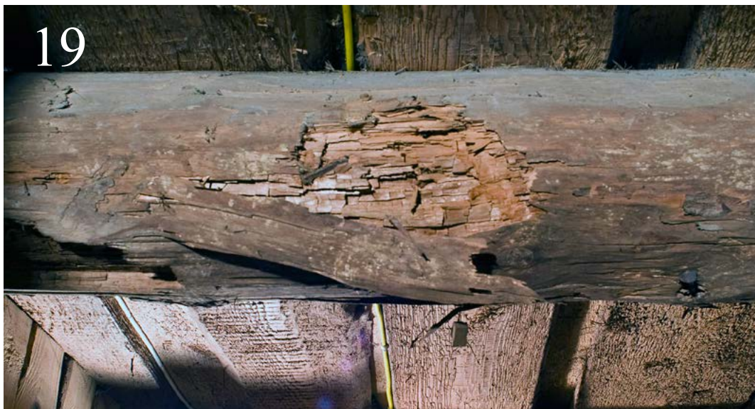
Eldre råteskader.
