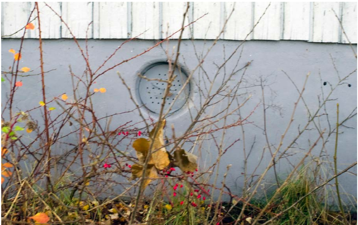
Over og under: Ventilasjonssluker i kjellermuren inn til krypkjeller. Det er kun ventilasjon i østmuren og det sikrer ikke luftsirkulasjon i kryprommet. Ventilåpningene er for små.
