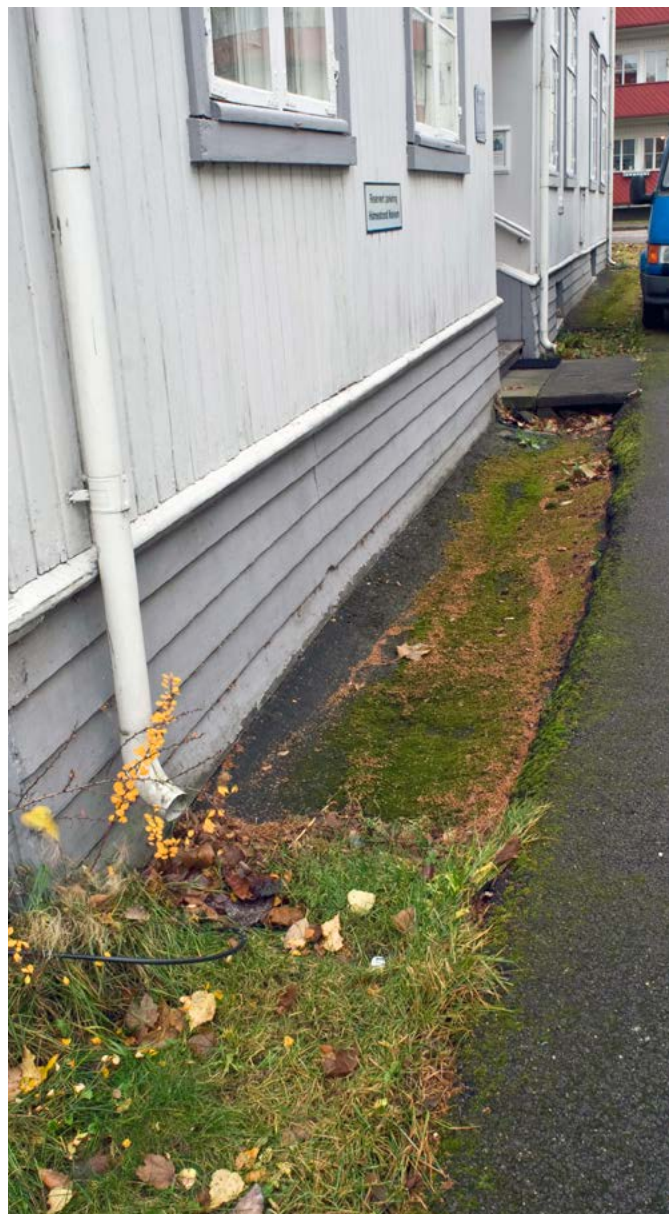
Vannrennen langs Nils Kjærs gate kunne vært effektiv men effekten er antagelig i stor grad borte pga gjen- groing, hull til grunnen og tildels manglende fall. Mulig rennen burde fortsatt ned til tverrgaten i øst. Slik det er nå bidrar rennen til fuktigere kjeller.
