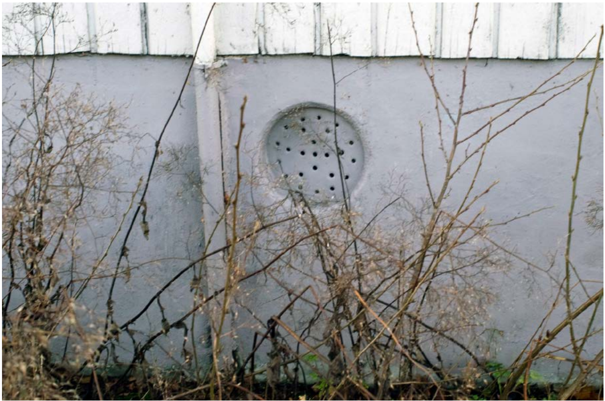
Over og under: Ventilasjonssluker i kjellermuren inn til krypkjeller. Det er kun ventilasjon i østmuren og det sikrer ikke luftsirkulasjon i kryprommet. Ventilåpningene er for små.
