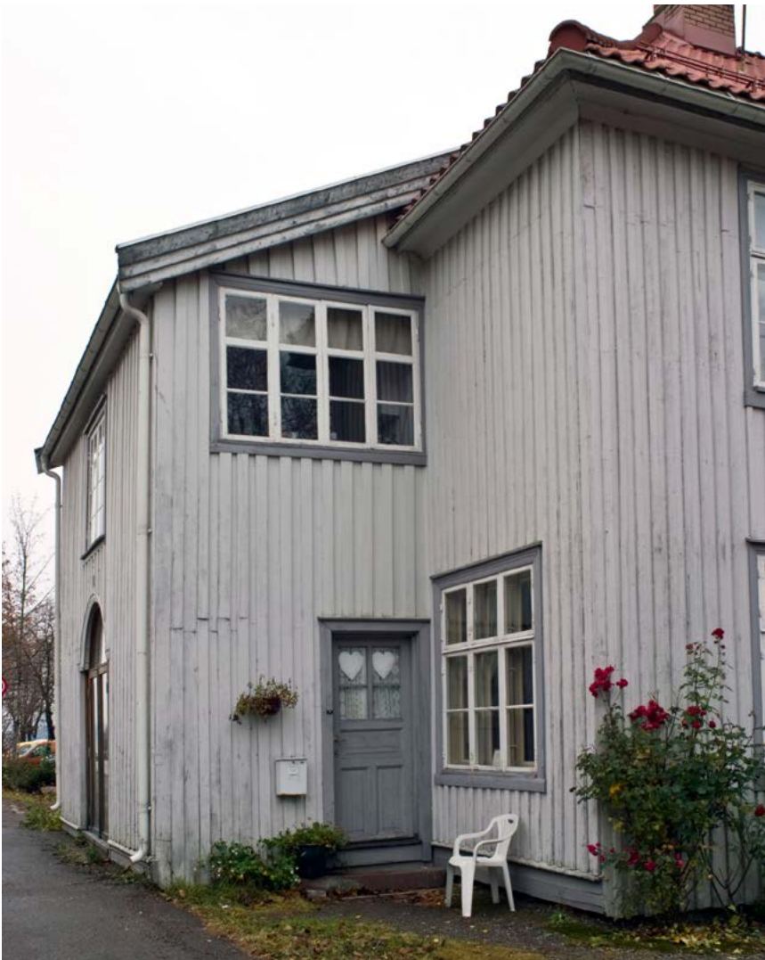
Trappehuset fra sydvest.
