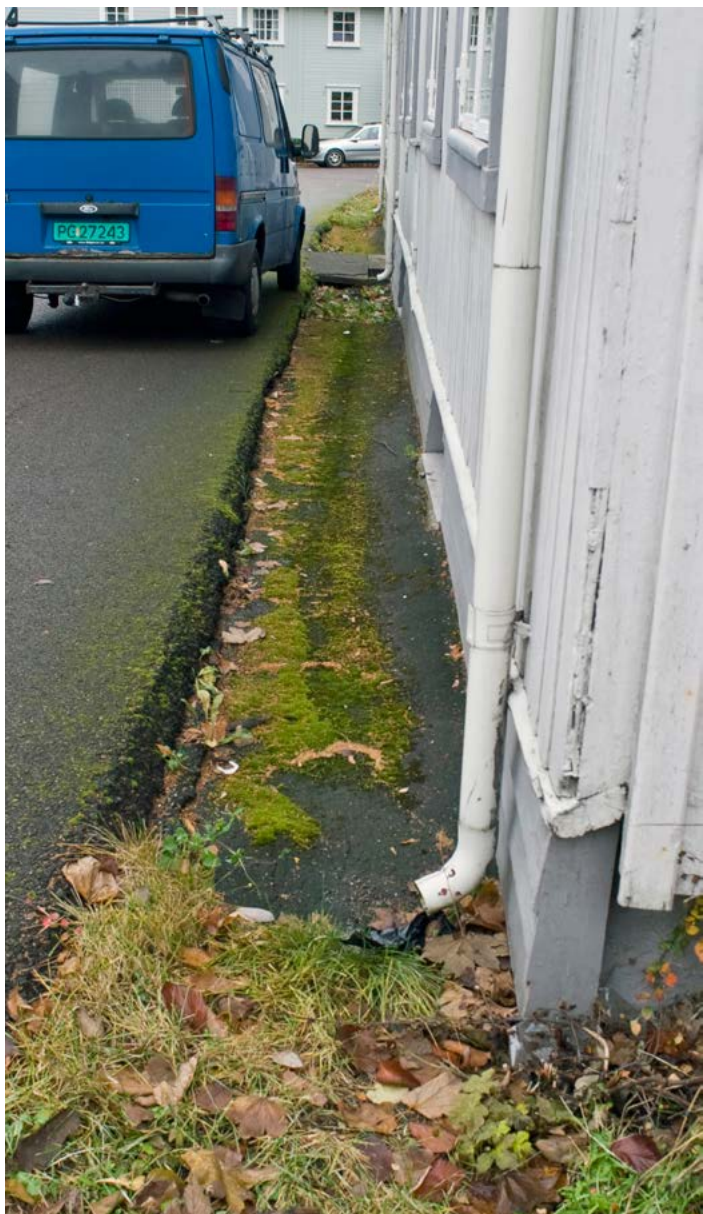
Vannrennen langs Nils Kjærs gate kunne vært effektiv men effekten er antagelig i stor grad borte pga gjen- groing, hull til grunnen og tildels manglende fall. Mulig rennen burde fortsatt ned til tverrgaten i øst. Slik det er nå bidrar rennen til fuktigere kjeller.
